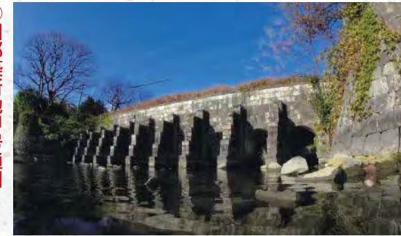
⑪ 旧郡築新地甲号樋門
